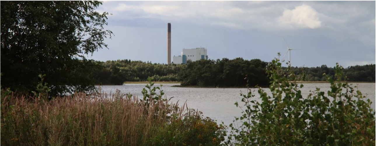
Fortumin hiilivoimala on Tahkoluotoa kaikista ilmansuunnista hallitseva maamerkki, joka näkyy kauas. Kuvat: Heli Koskela 2023.
