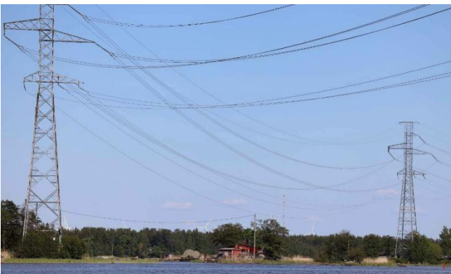
70-luvulla rakennettu 400kV:n voimalinja on osa saaristomais- maa. Ruovikkoihin niitetyt yhä pidemmät "veneväylät" ovat ominaisia maankohoamisrannikolla. Kuva: Heli Koskela 2023.
